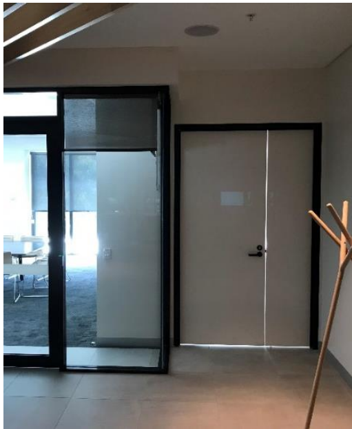
Photo 7.4.9 (i) – Access door Wirraway
