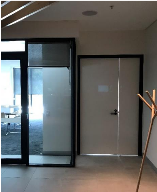
Photo 7.4.9 (i) – Access door Wirraway
